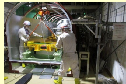
ウラン濃縮原型プラントにおける設備解体状況
