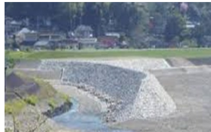
令和5年度に施工する導流堤（土石流の流れる方向を制御する）のイメージ（溪流①②部分）
