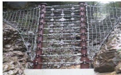
令和5年度に施工する杭式土石流対策（土石や流木を受け止め、泥や砂を少しずつ下流に流す）のイメージ（溪流④部分）
