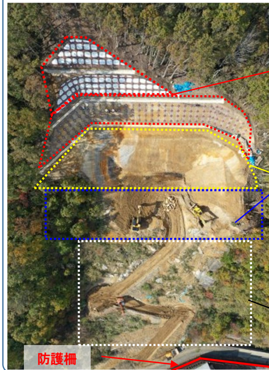
令和5年度に施工する導流堤（土石流の流れる方向を制御する）のイメージ（溪流①②部分）
