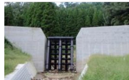
令和5年度に施工する杭式土石流対策（土石や流木を受け止め、泥や砂を少しずつ下流に流す）のイメージ（溪流④部分）
